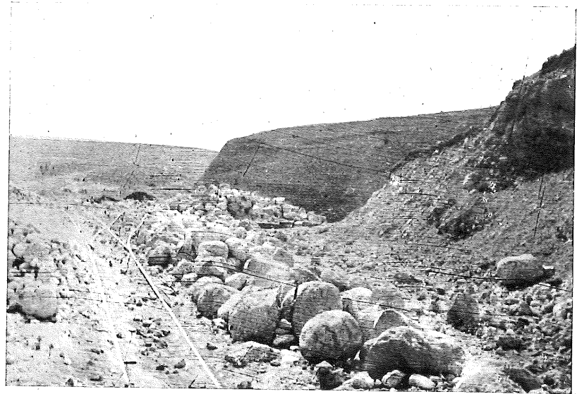
Fot. 32.—Potentes masas de derrubios miocenos, con grandes cantos de caliza cretácea redondeados, a la entrada del nuevo túnel de la vía del ferrocarril Madrid-Burgos, al sur de Linares del Arroyo.
