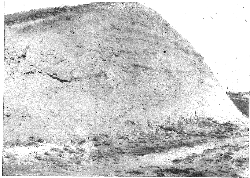
Fot. 31.—Desmorte de la vía del ferrocarril Madrid-Burgos, en construcción, que demuestra la potencia del depósito, con grandes cantos calizos, subhorizontales, superiores a los yesos y formación rojiza que los cubre, e inferiores a las margas y calizas sarmatienses.
